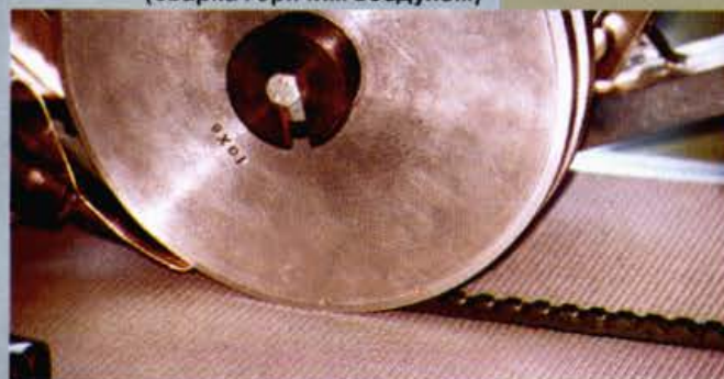
Установка профилей с помощью сварочной машины (сварка горячим воздухом)
