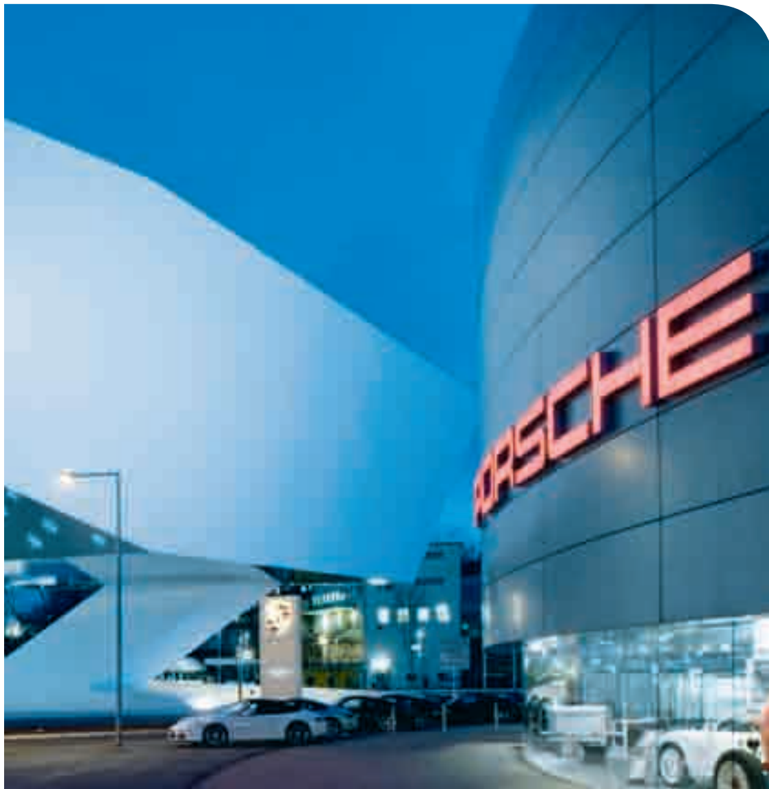
Музей Porsche, Штутгарт, Германия. Высокоэффективное отопле- ние и горячее водоснабжение.
