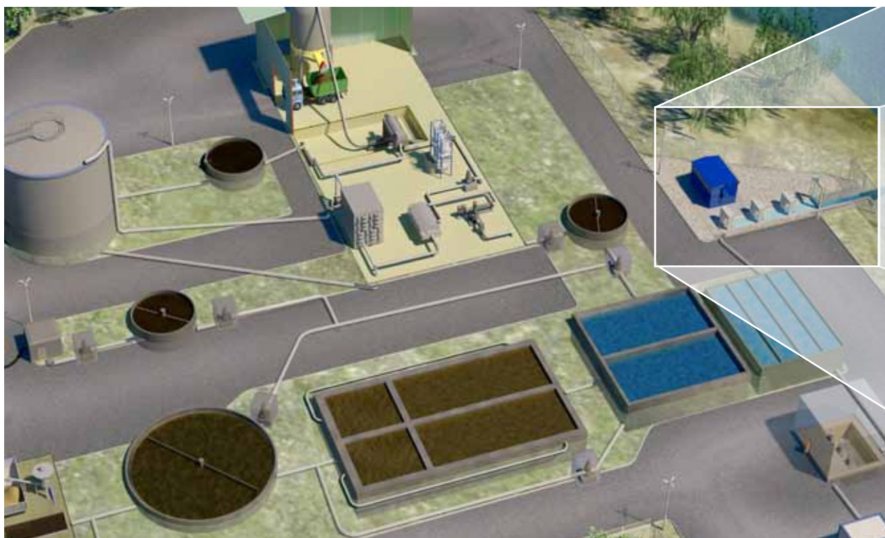
Общий вид типичной станции для очистки сточных вод с применением системы УФ дезинфекции WEDECO TAK 55 на последнем этапе обработки перед сбросом в открытый водоём
